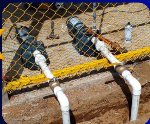
INSTALACIÓN DE BOMBAS CENTRÍFUGAS
