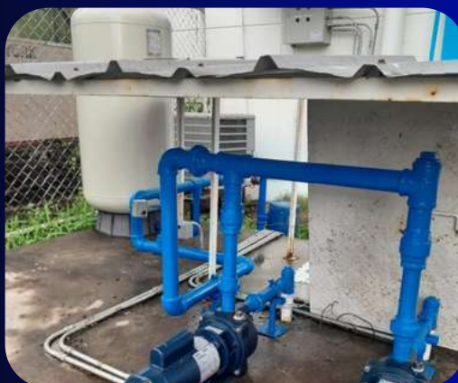
SISTEMA HIDRONEUMÁTICO EDIFICIO FOMAV MANAGUA, NICARAGUA
