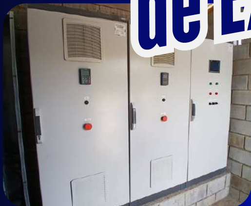
INSTALACIÓN DE PANELES DE CONTROL 200 HP
